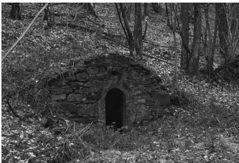
Foto 2 Burraia di Fonterinalda, interrata e caratterizzata dalle linee morbide e dall'architrave semicircolare. Foto: A. Chiti Batelli
