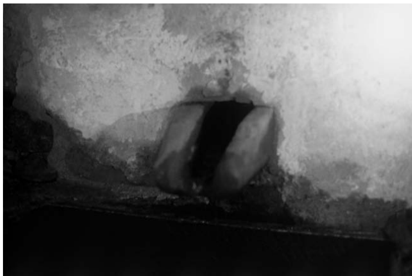
Foto 10 Interno della burraia di Fontassenzio (presso la casa colonica): particolare della canaletta in pietra. Foto: A. Chiti Batelli
